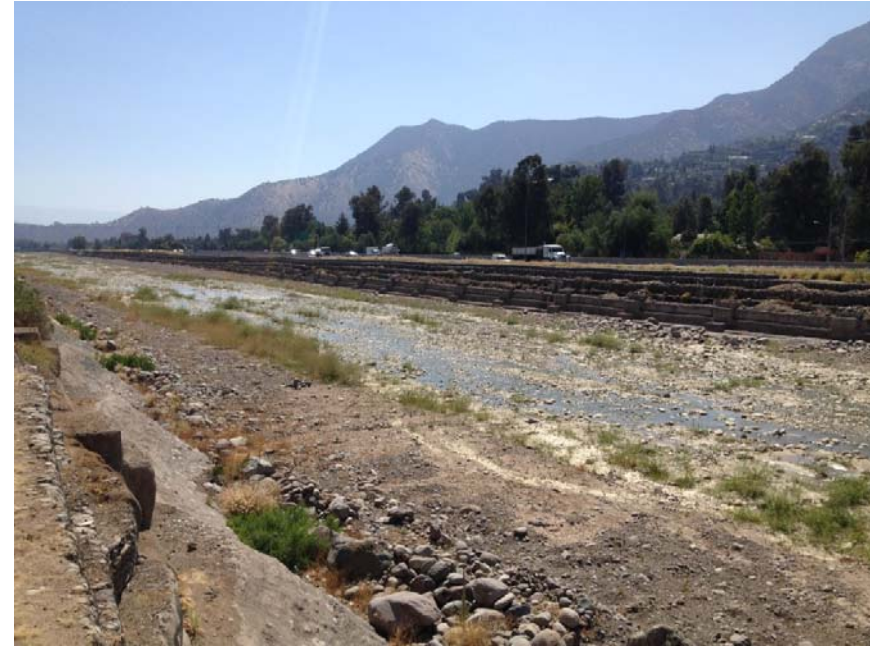
VISTA HACIA AGUAS ABAJO DEL CAUCE DEL RIO MAPOCHO EN EL SECTOR DE VITACURA
